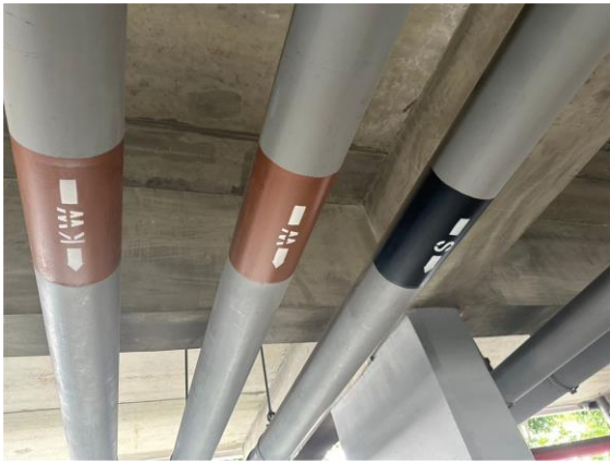
รูปที่ 2-27 ท่อรวบรวมน้ำเสียจากห้องพัสดุฝอย
